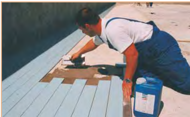
Fig. 2 Test de lipire pe un strat adeziv
