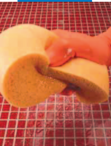
Umezirea suprafeței chituite înainte de curățare
