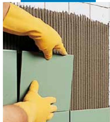
Montare plăci ceramice peste placare existentă
