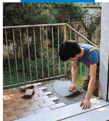
Aplicarea unor plăci ceramice peste hidroizolație, folosind adeziv Kerabond T + Isolastic
