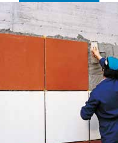
Montarea plăcilor ceramice de mari dimensiuni utilizând adezivul Kerabond T + Isolastic
